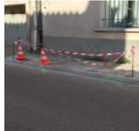
Vol de barrière suite à travaux
