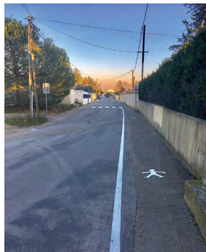
▲ Création d'un chemin piétonnier et réfection de l'éclairage rue de la Verrerie réalisations 2017
