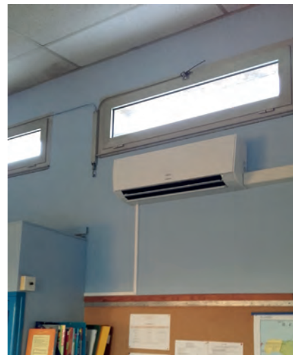
▲ Changement du chauffage de l'école élémentaire «Les Cèdres»
