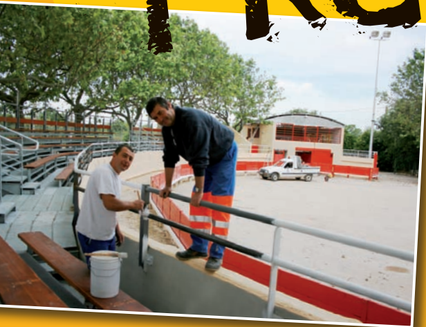
Travaux de finition dans les arènes avant l'inauguration.
