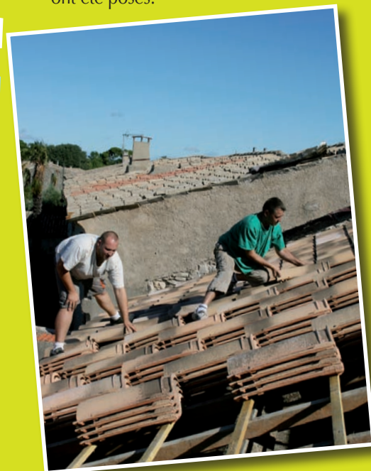
La toiture de la Maison du Peuple a été refaite.
