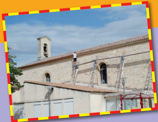
Cet été, le temple a été équipé de cheneaux.
