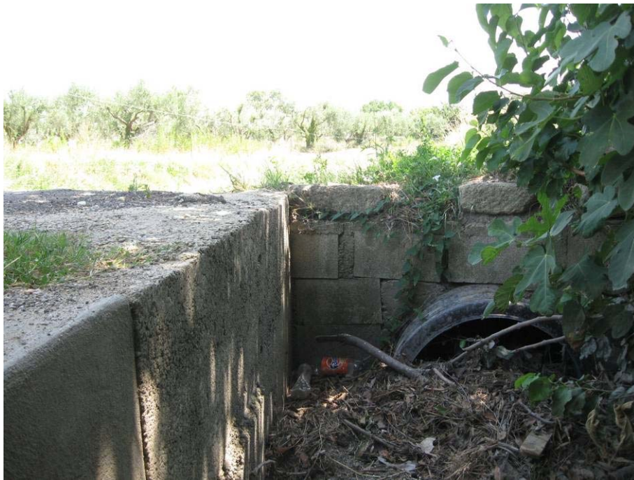
Figure 6 : Section d'un fossé réduite par des débris.
