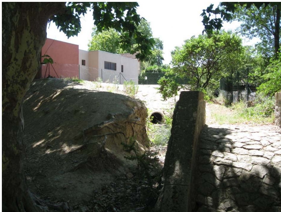
Figure 3 : Remblai et aménagement hydraulique à Langlade
