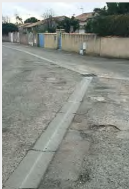
▲ Réfection des enrobés au lotissement "Les Iragons"
