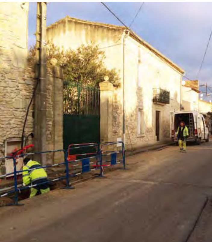
▲ Enfouissement réseau EDF rue de Vergèze
